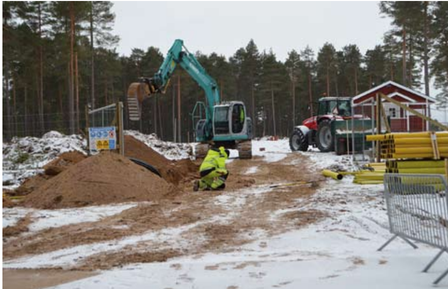
Bygget i Hemus startade 15 oktober. Fram till nu sker markarbete och gjutning av betongplatta. Sedan fortskrider arbetet med byggnaden efter Vasaloppet 2017. FOTO: Johan Trygg.
