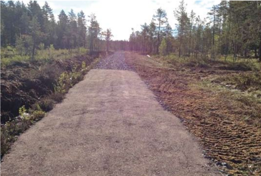
Avjämnning av skidspårets underlag i symbios med Cykelvasabanans skapande = snösåkring.
